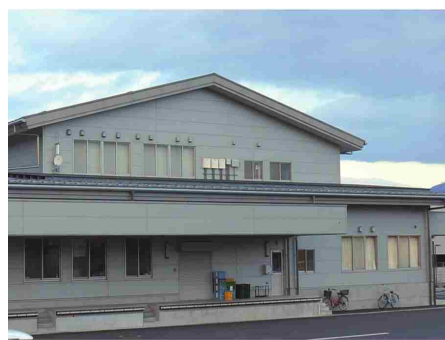
太陽光パネル設置屋根（南部学校給食共同調理場）
