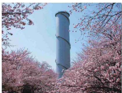
佐久発電所サージタンク
