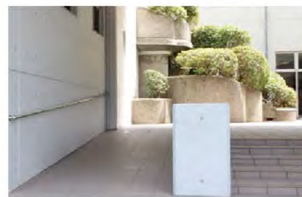
玄関付近にある手すり付きのスロープ 車椅子やベビーカーのまま建物に入りやすい
