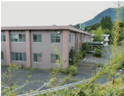
再活用が求められる西群馬病院跡
