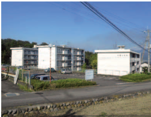
改修を望まれる市営住宅
