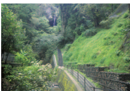
復旧された遊歩道
