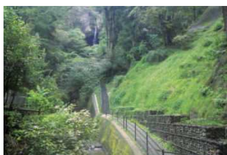
復旧された遊歩道
