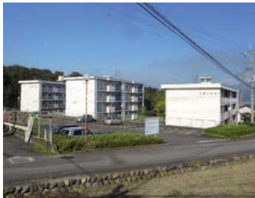
改修を望まれる市営住宅
