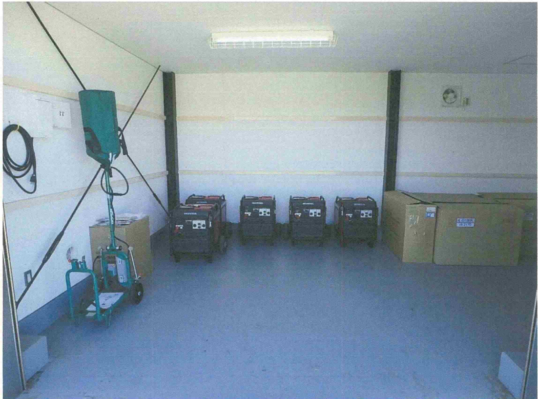
備蓄倉庫（可搬式照明、発電機）
