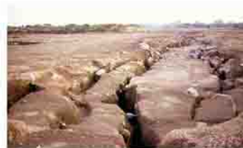
半田中原・南原遺跡の地割れと陥没の跡
