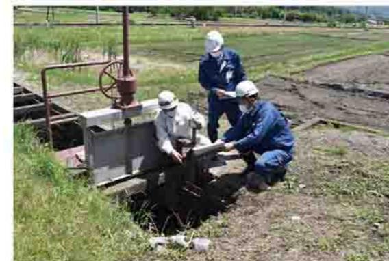
5月20日から6月1日に市内各地で、土砂災害危険箇所点検が実施されました。これは、過去に土砂災害が発生した箇所を中心に、水路・道路・林道・ため池等の計84カ所で、土砂の流出や水路の詰まりなどの状況を一斉に点検するもの。25日は川島地内で、久保田川と舞台用水の2カ所の水路点検が行われました。
