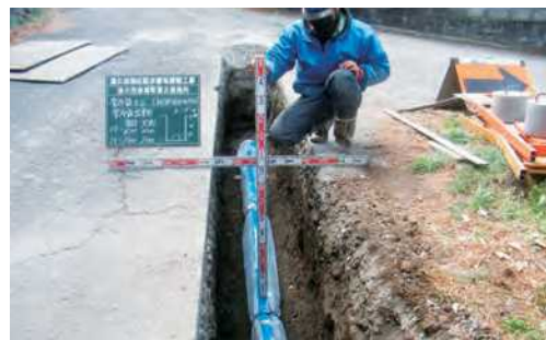
水道管布設工事
