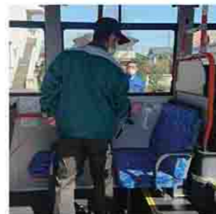
抗菌コート施工
