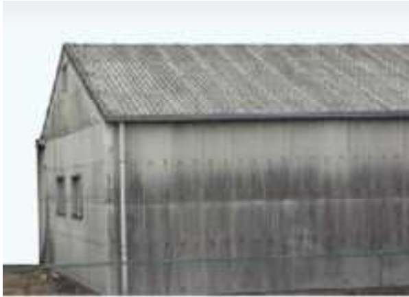
石綿含有スレート波板（屋根・外壁）
