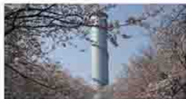
サージタンク
