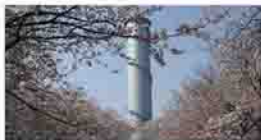
サージタンク
