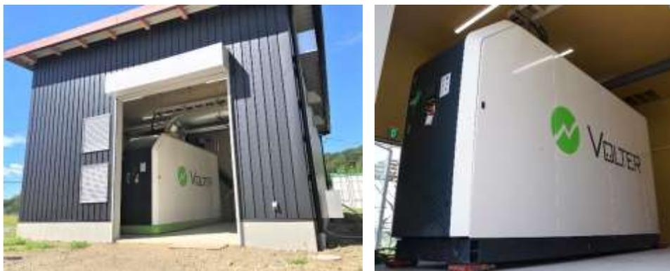
超小型バイオマス熱電併給設備
