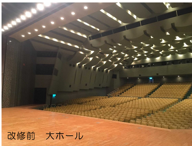
渋川市民会館耐震改修工事写真
