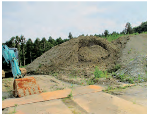
五輪平地内の危険な盛土
