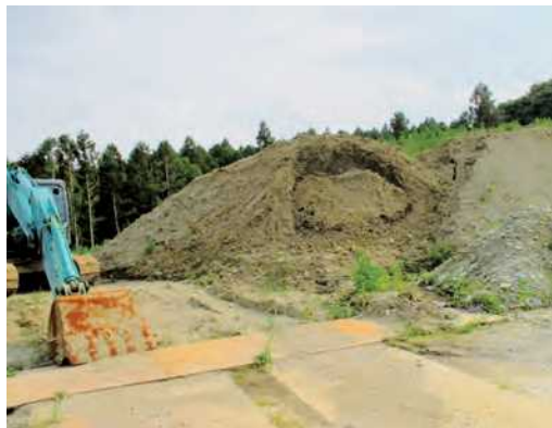
五輪平地内の危険な盛土
