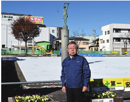
▶ 整備工事が進む駅前広場
