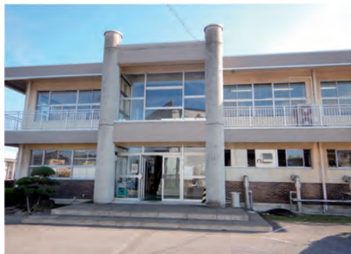
施設の老朽化(築53年)により更新が待たれる阪ノ下浄水場
