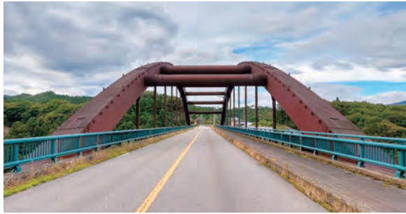
補修工事が行われる沼尾大橋
