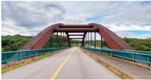
補修工事が行われる沼尾大橋
