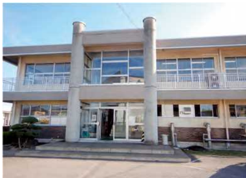
施設の老朽化(築53年)により更新が待たれる阪ノ下浄水場
