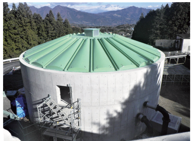
物間沢水質管理センター(最終沈殿池)
