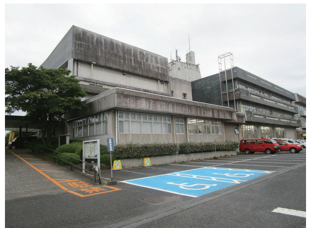
老朽化が進む市役所本庁舎
