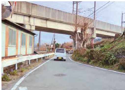
拡幅が待たれる 市道大塚大輪原線（川島地内）
