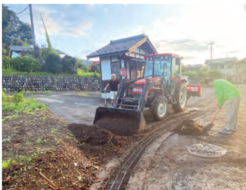
中井公衆トイレ付近の土砂撤去作業
