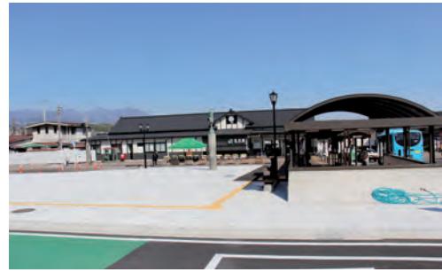
整備が進む渋川駅
