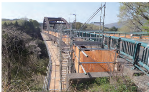
補修工事中の沼尾大橋
