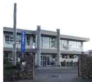
▲老朽化が進む阪ノ下浄水場
