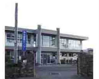
▲老朽化が進む阪ノ下浄水場
