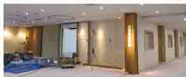
◀工事は順調に進んでいます (11月13日撮影)
