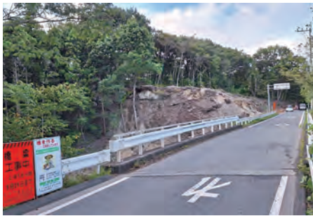
市道折原川島線道路改良工事
