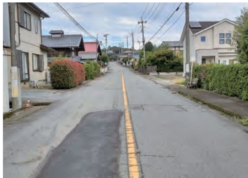
水路工事と併せて実施される 舗装復旧工事
