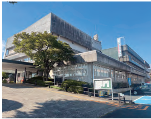
老朽化した市役所本庁舎
