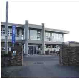
阪ノ下浄水場
