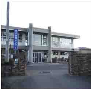
阪ノ下浄水場
