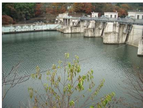
綾戸ダム(群馬用水取水口)
