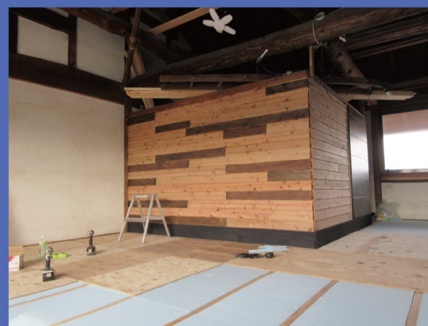
▲2階の趣味スペースとなる予定の旧倉庫
