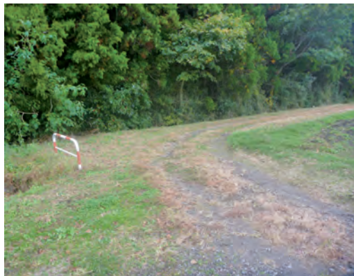
自治会要望の5-2120号線舗装
