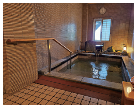
よくそう ふち 浴槽の縁まで だん さ 段差がなく、 て せつ ち 手すりが設置 された温泉 おんせん
