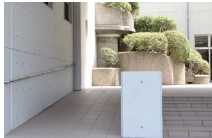
げんかん み きん て 玄関付近にある手すり付きのスロープ 車椅子やベビーカーのまま建物に入りやすい
