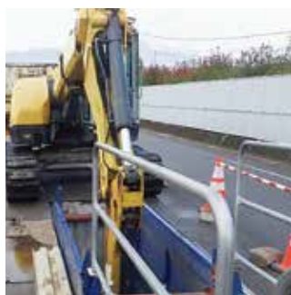
渋川地区で進める下水道新規整備
