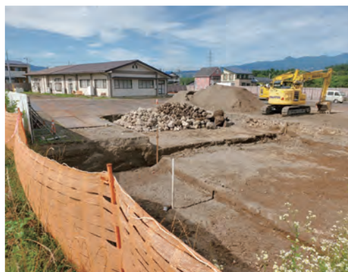
古巻公民館敷地の汚染土壌の撤去作業
