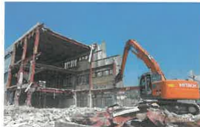
鉄骨造の解体
