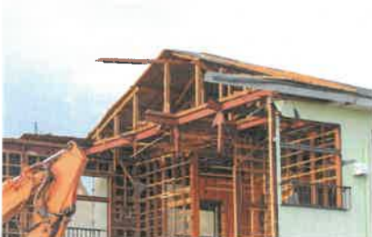
木造住宅の解体
