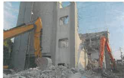
RC構造の解体
