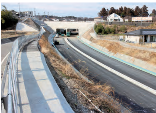
着々と進む渋川西バイパス工事 (入沢地区)
