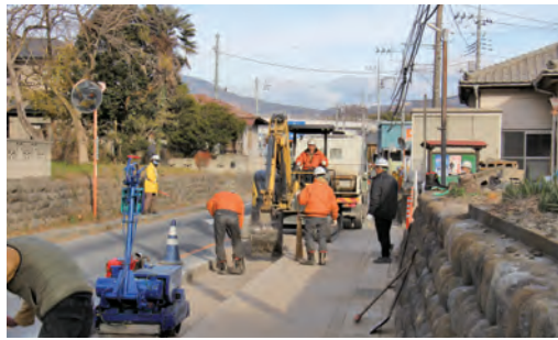
下水道管路敷設工事（金井地内）
