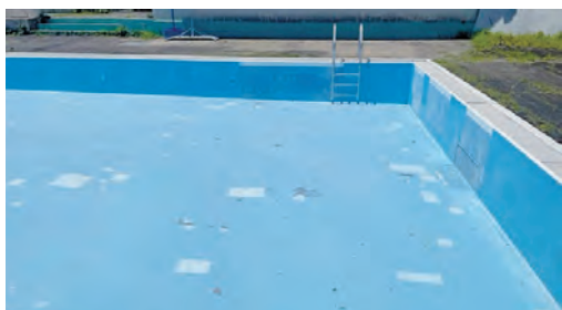
補修が実施される 渋川北小学校の小プール
