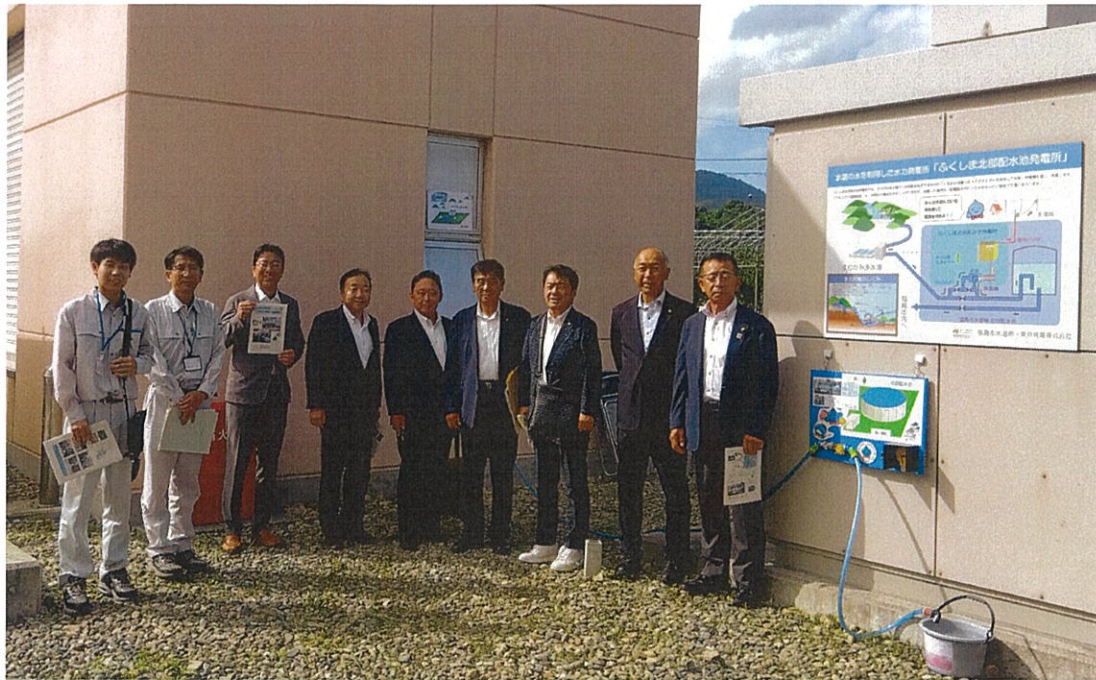
ふくしま北部配水池発電所
