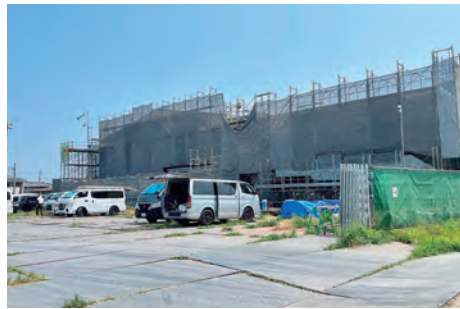
共生社会実現に向け建設中の公民館
