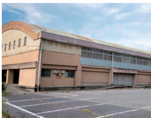
老朽化が著しい市民体育館
