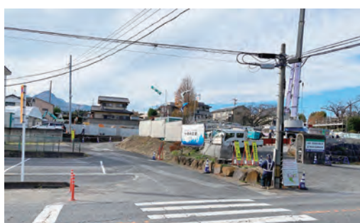
拡幅改良予定の平形眼科南の市道
