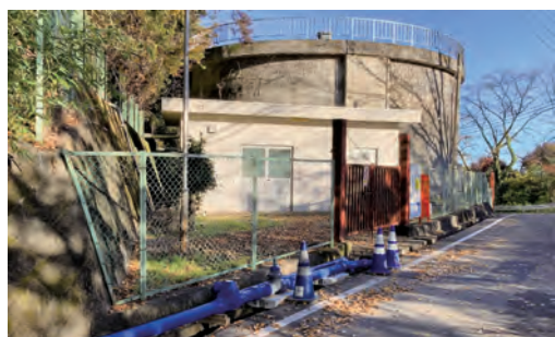
青い仮設送水管の設置が進む有馬配水池
