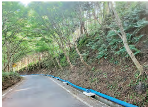
水道水PFAS汚染改善対策として急ピッチで進む仮設工事中の管路
