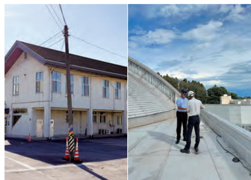
撤去が進まぬ危険な電柱(子持行政センター) 雨漏り現地調査(北橋中学校体育館)
