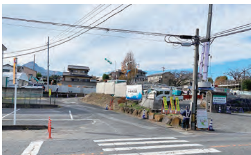
拡幅改良予定の平形眼科南の市道
