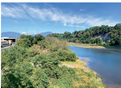
県による堤防のかさ上げ整備が予定される利根川の坂東橋上流部
